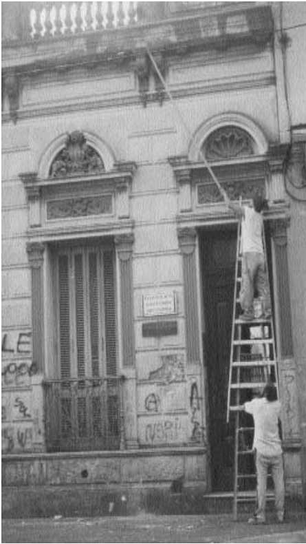
Buenos Aires 2003: membri della Federación Libertaria Argentina intenti a ristrutturare la sede storica di questa organizzazione. Malgrado il movimento anarchico abbia subito a più riprese durissime persecuzioni (in particolare a partire dagli anni Trenta), ancor oggi mostra una notevole vitalità
